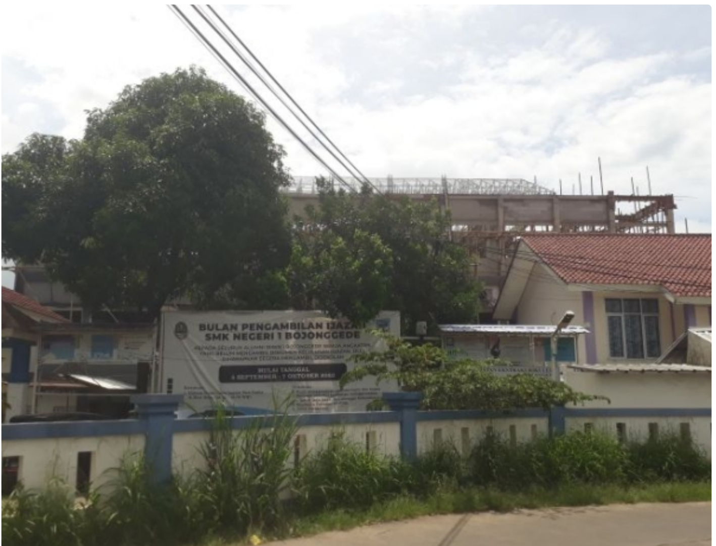
Pembangunan ruang kelas baru di SMKN 1 Bojonggede, Kab.Bogor
